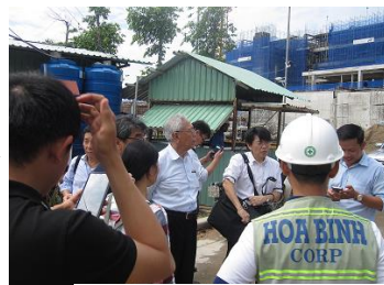
フーコック工事現場
